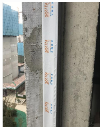
窗框栏杆安装
