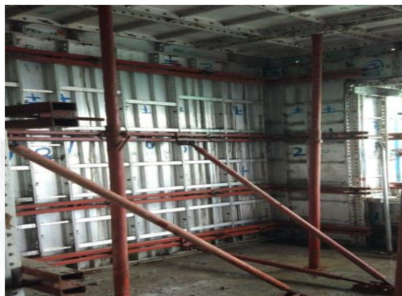
混凝土浇筑完成
