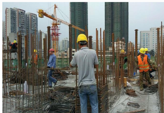
墙柱钢筋绑扎
