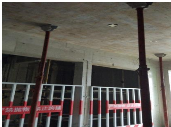
铝合金模板拆除，仅留部分独立支撑体系
