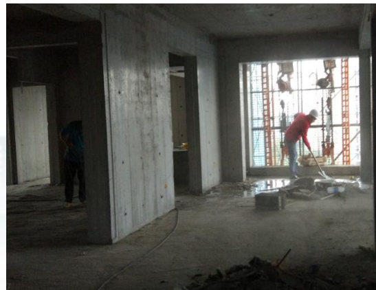
支撑已拆除，楼层清扫
