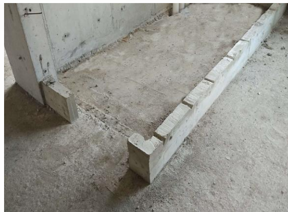
铝合金模板拆除，仅留部分独立支撑体系
