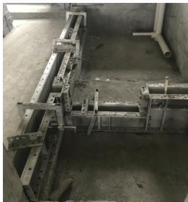
铝合金模板拆除，仅留部分独立支撑体系
